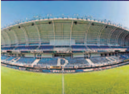
Molde FK har fått et nytt og moderne anlegg uten løpebaner.
